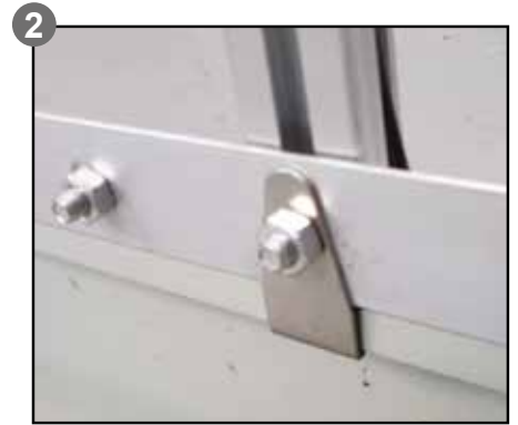
Crochet à positionner Haken anbringen Attach hook
